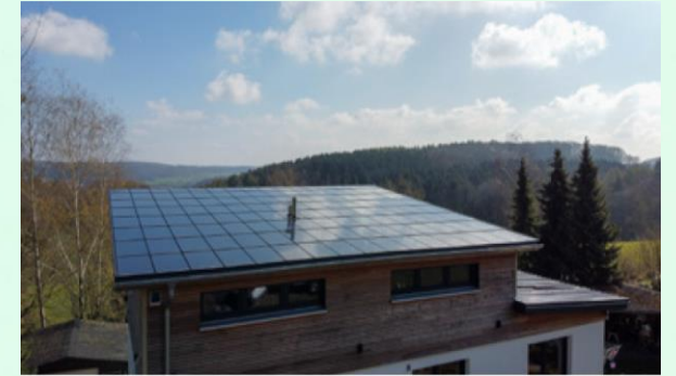
Solardach am Beispiel von www.ennozie.com
